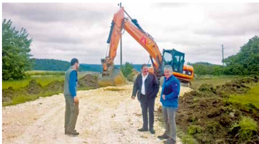
Bauarbeiten am HLP Ensfeld zur Vergrößerung und verbesserten Befahrbarkeit
